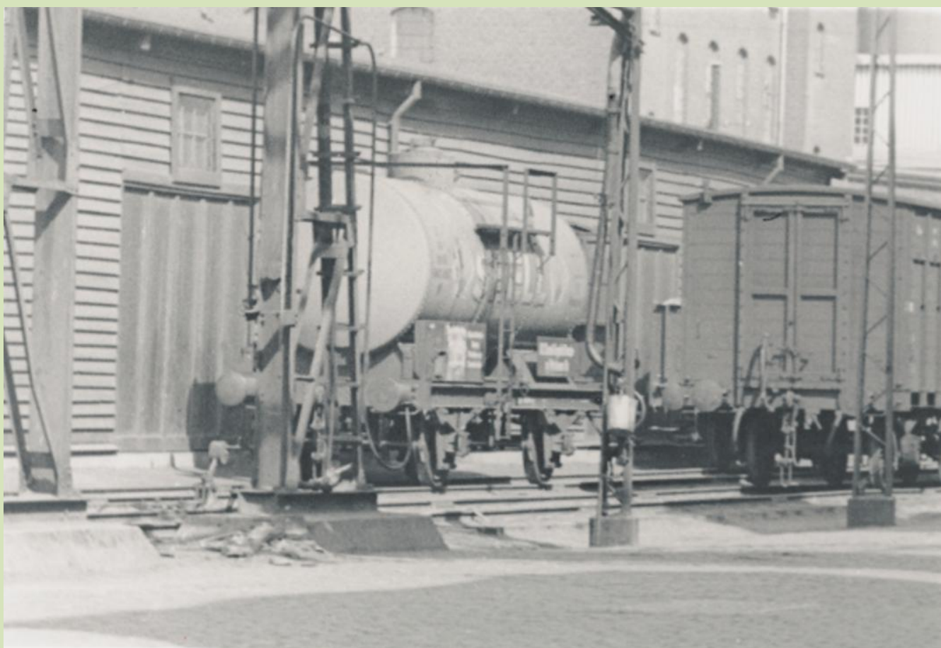
ZE 502 987. På Dansk Sojakage Fabrik. D. 12.04.1934. forunderligt nok har vognen (fået?) cylinderpuffer, man kunne have forventet – at med byggeår 1913. havde det været kurvpufer. Arkiv.: På Sporet.
