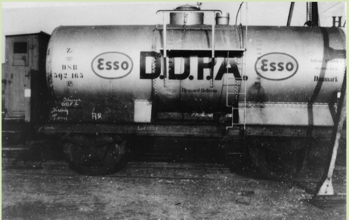
ZE 502 165 i 1947. vognen viser overgangen fra DDPA til Esso. Alle påskrifter sidder på tanken og vangen, pladen til venstre bruges kun til skrivefelt. Foto.: PEC. Arkiv.: DMJK.
